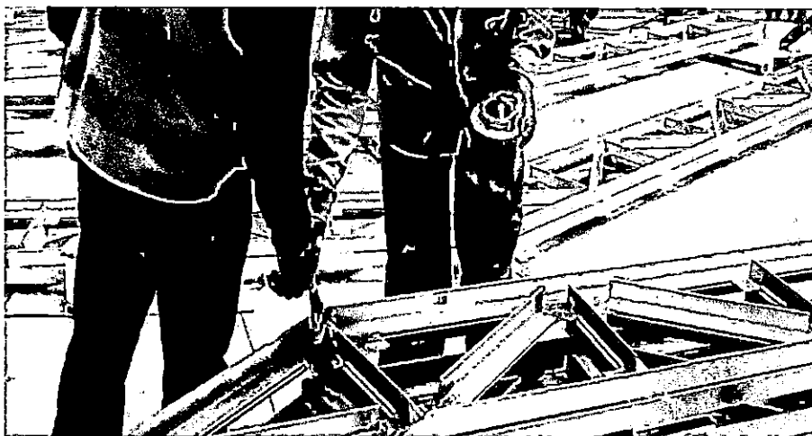
IMAGEN 05 Retoques de pintura en la estructura metálica en obra.
