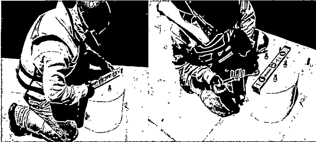
IMAGEN 11 Nivelación y ajuste de Tuercas.
